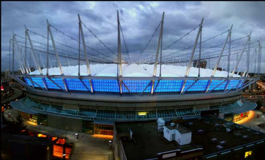
Vista nocturna del estadio Olímpico de Vancouver. Su cubierta especial de lona requiere un constante mantenimiento.
