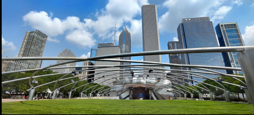
Impresionante estructura de acero que forma parte del auditorio para conciertos "Jay Pritzker Pavilion", ubicado en el "Millenium Park" de "Chicago" y que sustenta los juegos de luces.
