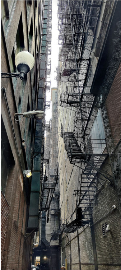
Escaleras de salida de incendios que nos recuerdan a los barrios del Chicago de 1920
