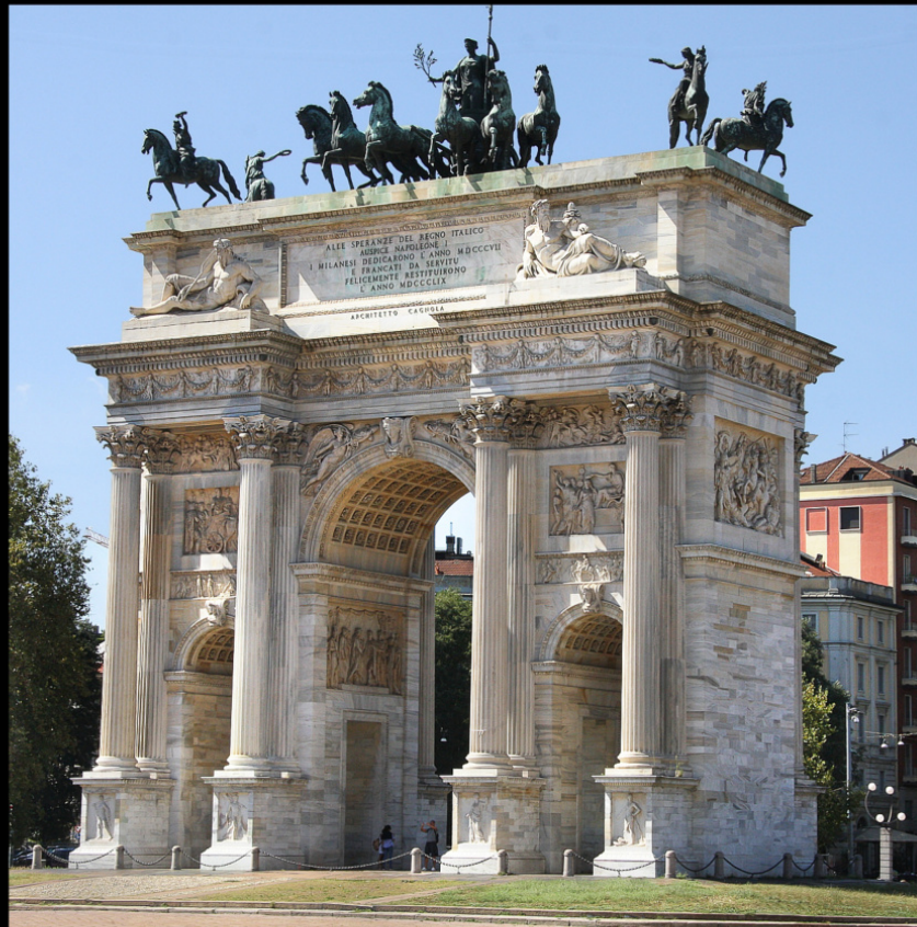
La "Puerta Sempione" en la ciudad de Milán, Italia, es un "Arco de la Paz" del siglo XIX cuyos orígenes se remontan a una puerta mucho anterior instalada en las murallas romanas de Milán.
