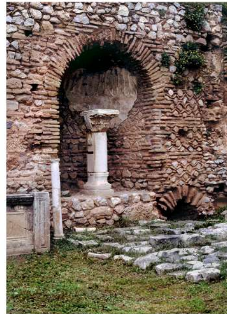
Paredes que a duras penas permanecen aún en pie, de lo que son los restos del antiguo templo de Apolo en Delfos.
