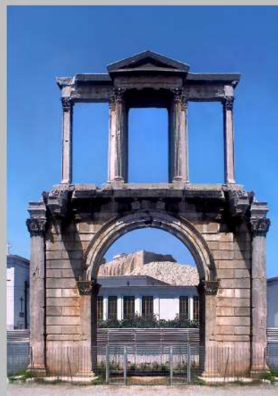
Arco de Adriano. El Emperador romano Adriano fue arconte de Atenas y lo mando construir. Tuvo un amante griego.
