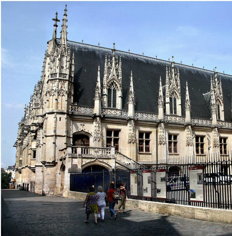
El palacio de justicia de Rouen, de finales del gótico es prácticamente resultado de una reconstrucción neogótica, con detalles del flamígero en la balaustrada de la base del tejado.
