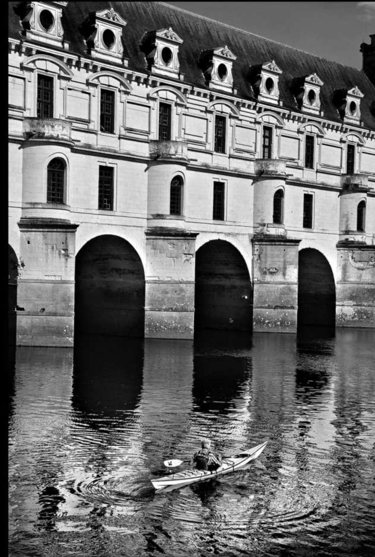
Arcos y pilares que sustentan el castillo de Chenonceau y que permiten por debajo el paso de pequeñas embarcaciones. Francia. 2017
