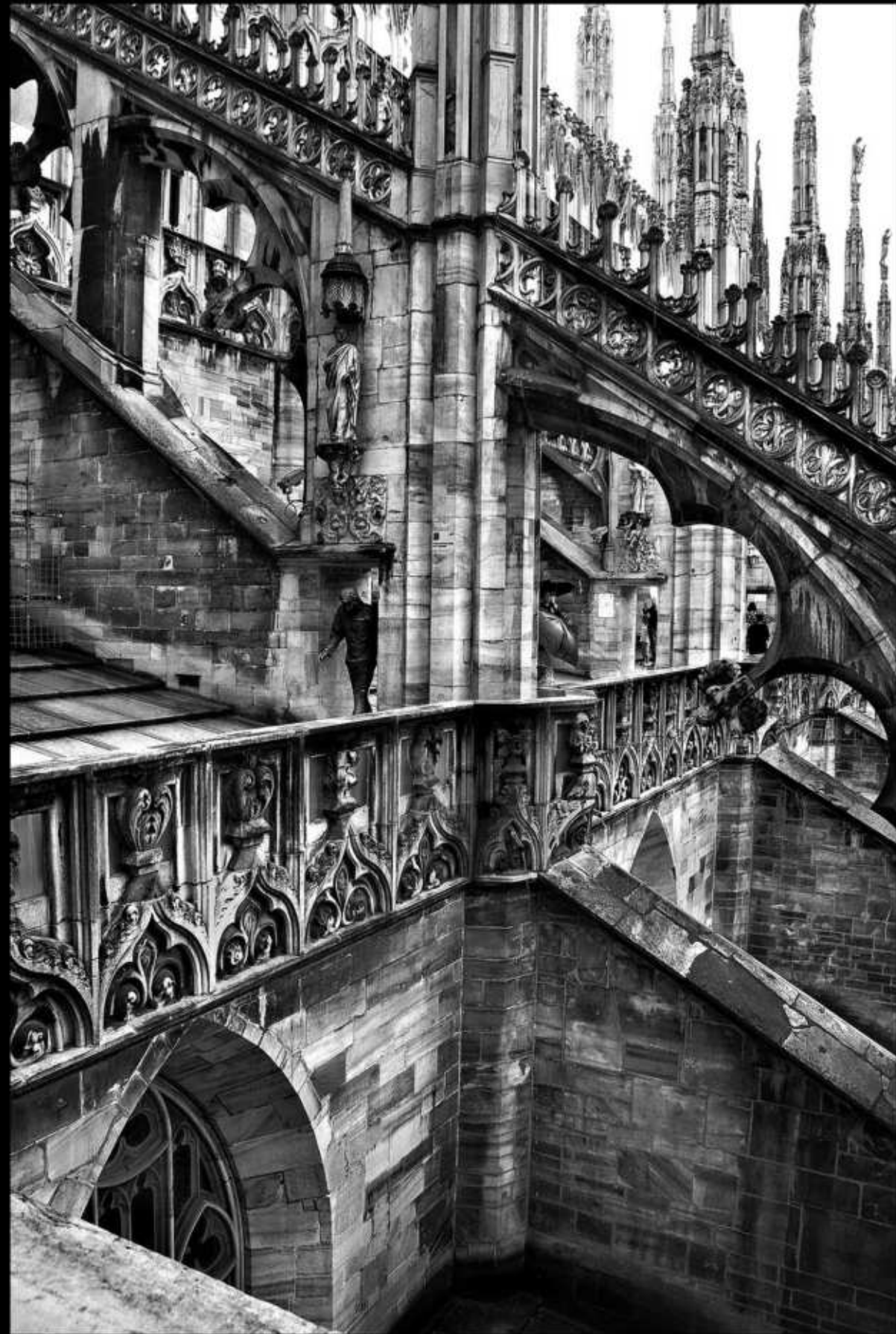
Paseo por el sorprendente techo y laberinto de contrafuertes que sostienen los muros de la catedral Duomo de Milán. Italia. 2018
