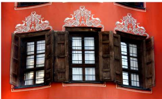
Construcción típica de casa con fachada coloreada de la ciudad de Plovdiv.
