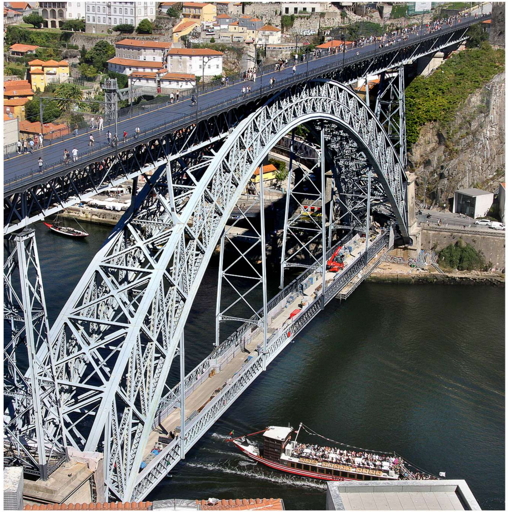
Impresionante vista al completo del puente de Don Luis en la que se aprecian sus dos niveles, una parte superior para el paso de trenes y una parte inferior para los coches
