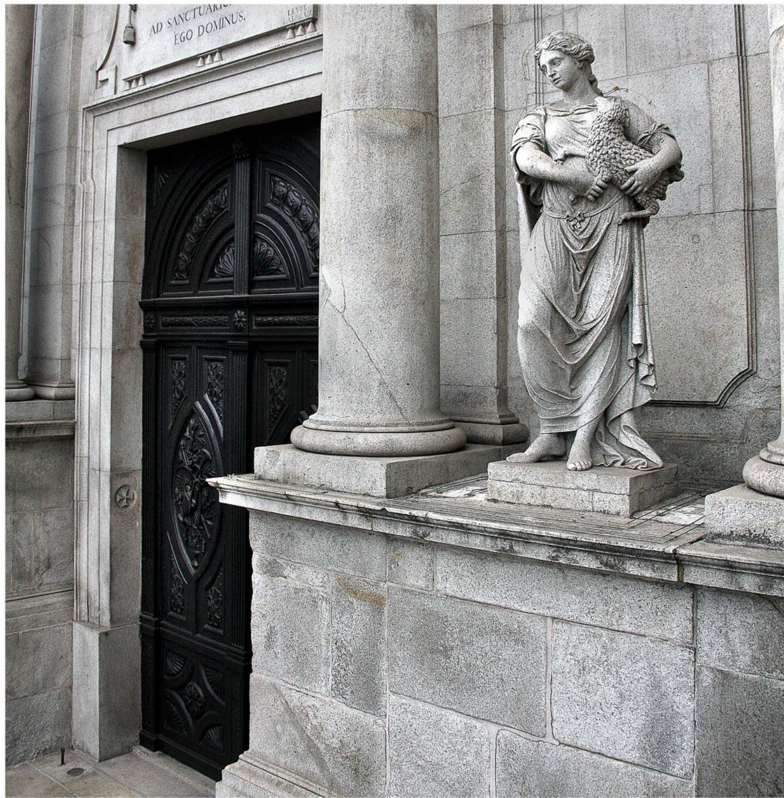
Acceso lateral a la capilla y al museo de la Iglesia de San Francisco
