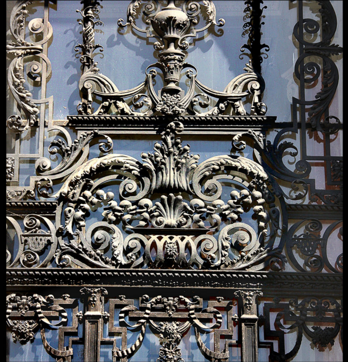
Fabuloso y minucioso trabajo de forja realizada en hierro fundido el que adorna la fachada de uno de los más conocidos cafés de la ciudad de "Budapest" en Hungría.
