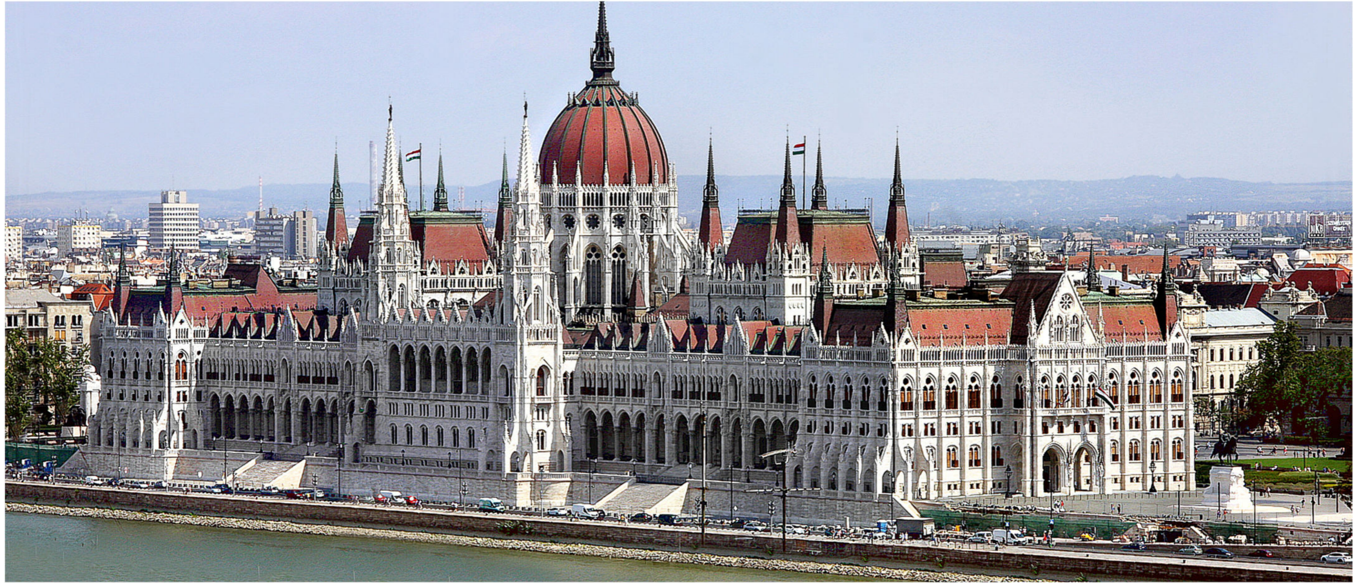
El edificio del parlamento de "Hungria" en "Budapest", fue construido
