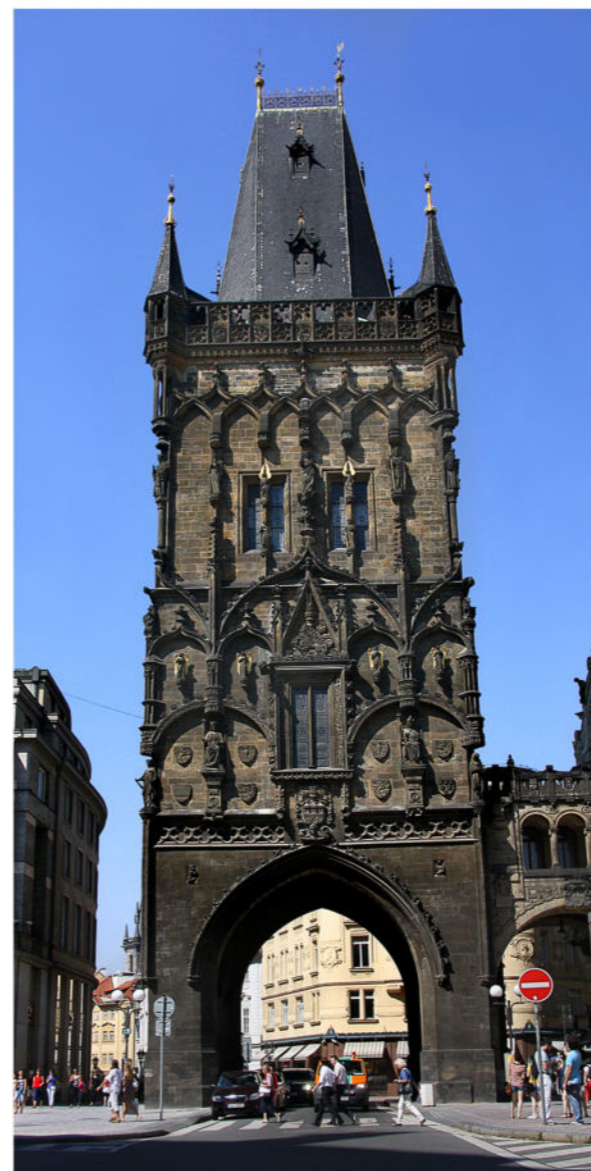
La "Torre de la Pólvora" es una de las 13 puertas originales de la "Ciudad Vieja" de Praga. Chequia
