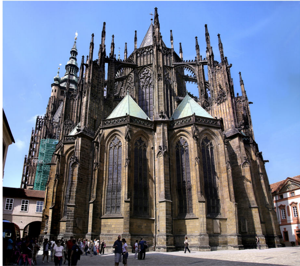
Fachada posterior de la "Catedral gótica católica de San Vito" en cuyo interior se ubica el ábside y que forma parte del conjunto monumental del "Castillo de Praga". República Checa.
