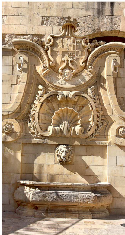
Fuente de Wignacourt, una más de las bellas fuentes en La Valeta, Malta
