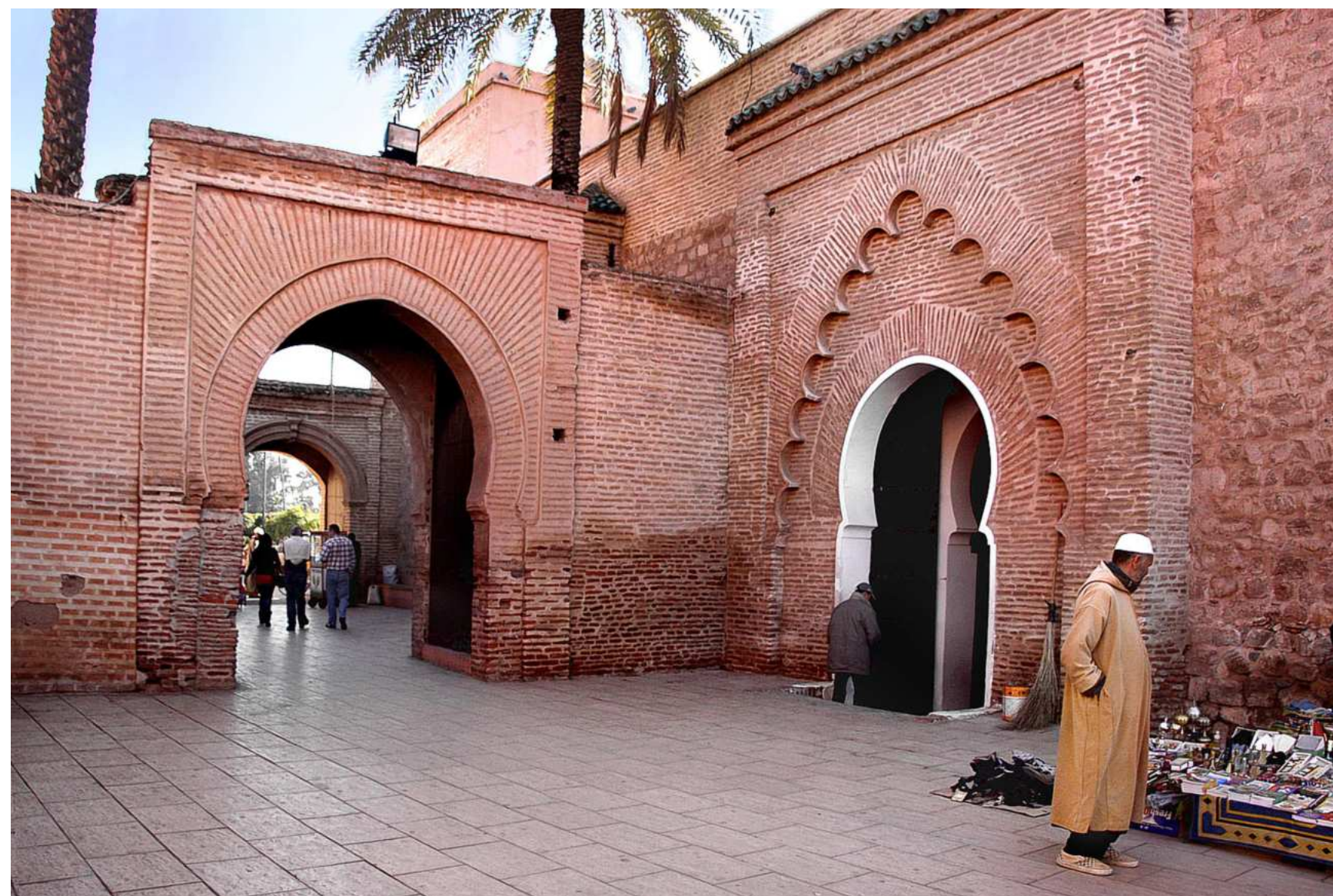
Plaza y puerta de acceso a la mezquita de "Koutoubia", Marrakech, cuyo nombre significa "mezquita de los libreros", debido a los numerosos puestos de libros que en ella se han instalado.
