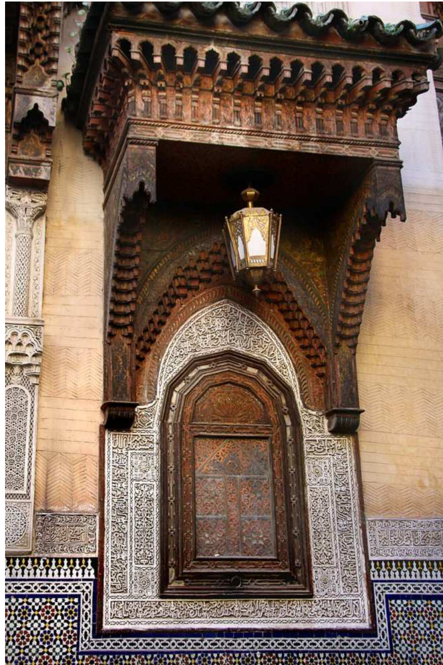
Ventana en la fachada de el "Zaguiat Sidi Ahmed Tijani" un edicio regilioso del centro de Fez.
