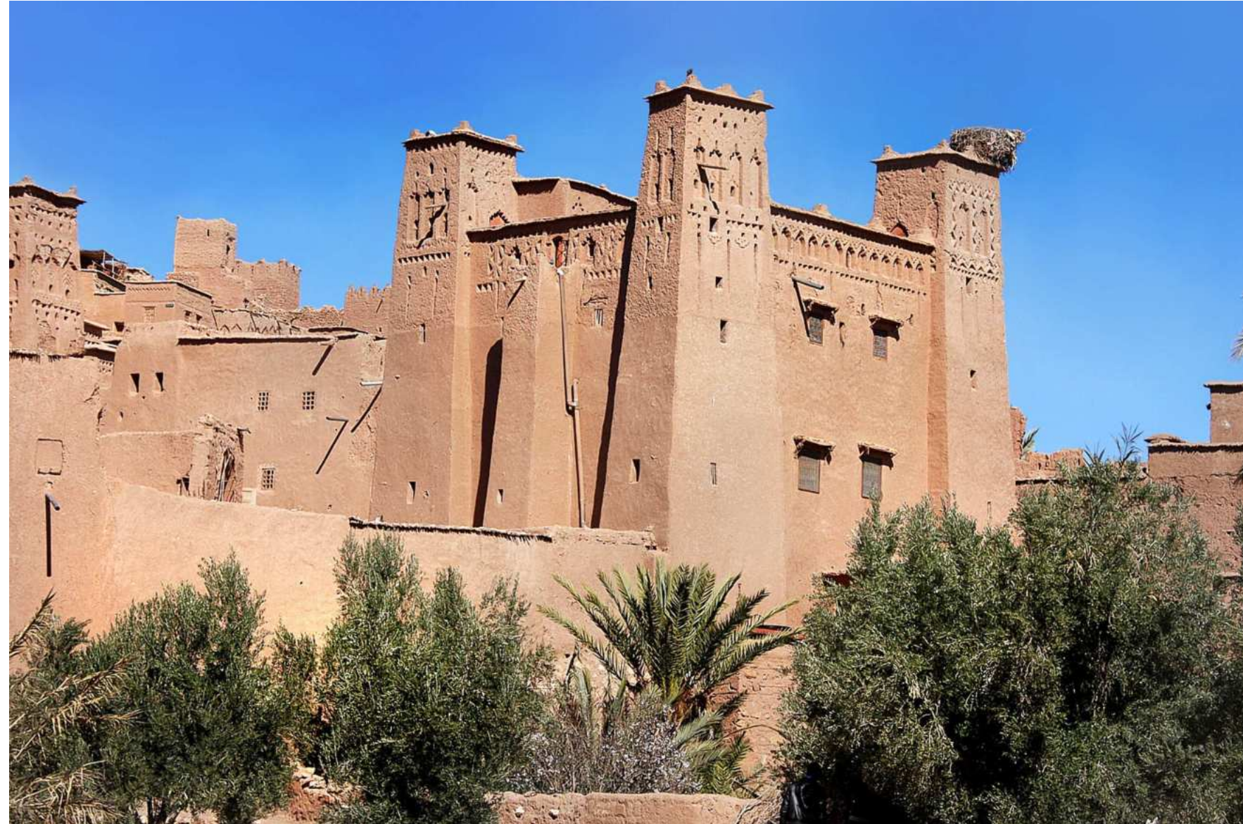
ksar de "Ait Benhaddou". Agrupación de viviendas en el interior de murallas defensivas reforzadas por torres angulares. Una completa muestra de técnicas de construcción presaharianas. Quarzazate
